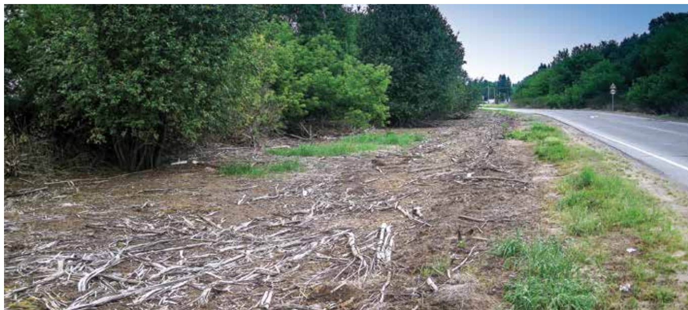
Полоса отвода автодороги после обработки гербицидами
